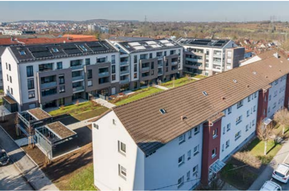
Rosswager Str. 4 und 6–10 in Stuttgart-Rot
