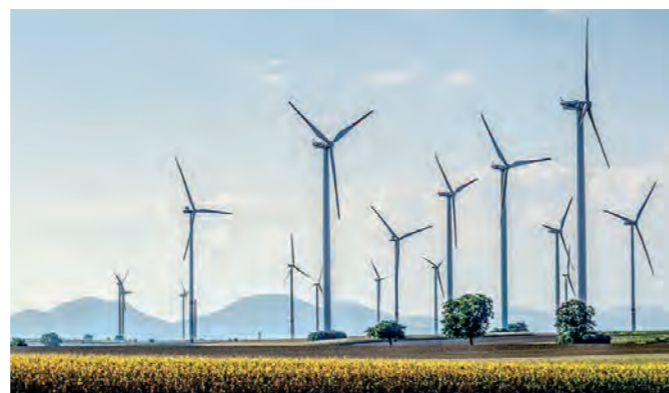
Ausbau der Windenergie
