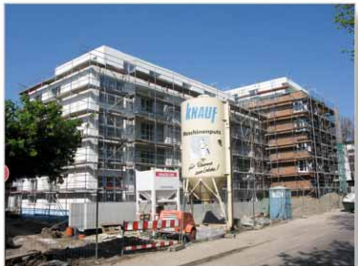
Abriss und Neubau an der Gundelsheimer Straße
