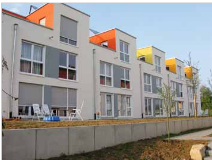
Neubau von 5 Reihenhäusern in Stuttgart-Zazenhausen
