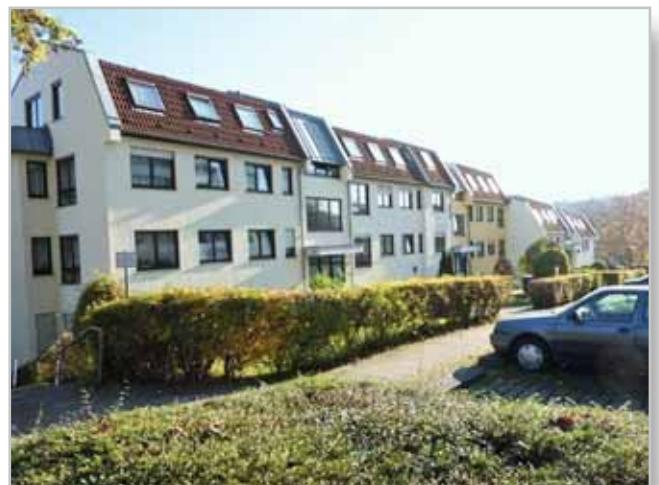
Fassadensanierung Max-Brod-Weg 7-11 u. Eulenbühlweg 4 in Stuttgart-Freiberg
